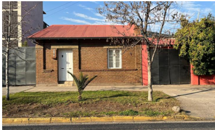
Figura 35. Ejemplo de rehabilitación de vivienda en el barrio El Aguilucho Fuente: DAU, 2022
